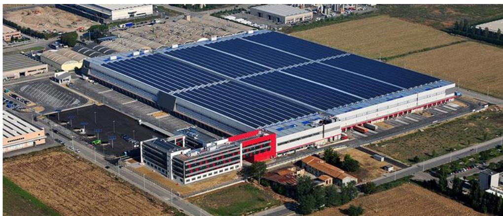
L'impianto fotovoltaico (FV) ha **potenza complessiva pari a 2.906 kW**
