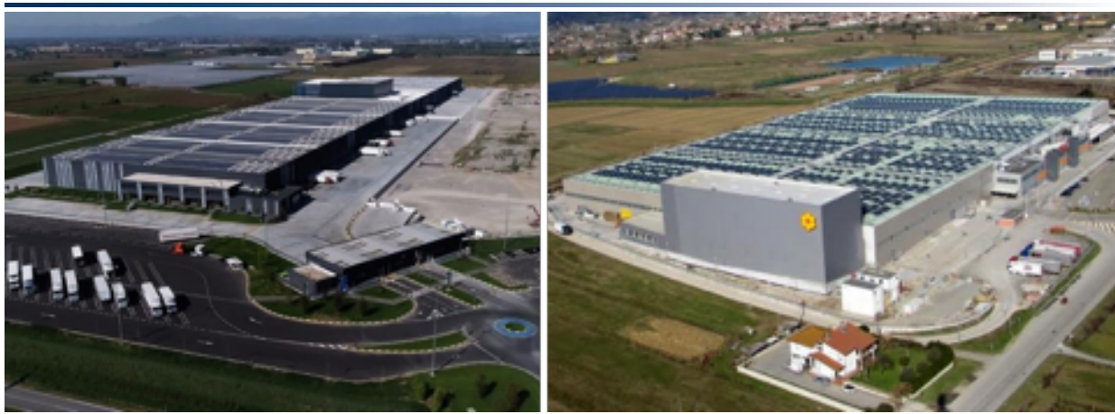
Figura 2.8 – Esempi di Ce.Di. ad elevato tasso di automazione: Italtrans a Calcio (BG) per Agorà e Conad del Tirreno a Montopoli val d'Arno (PI)
